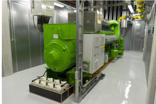
générateur BHKW Diekirch
